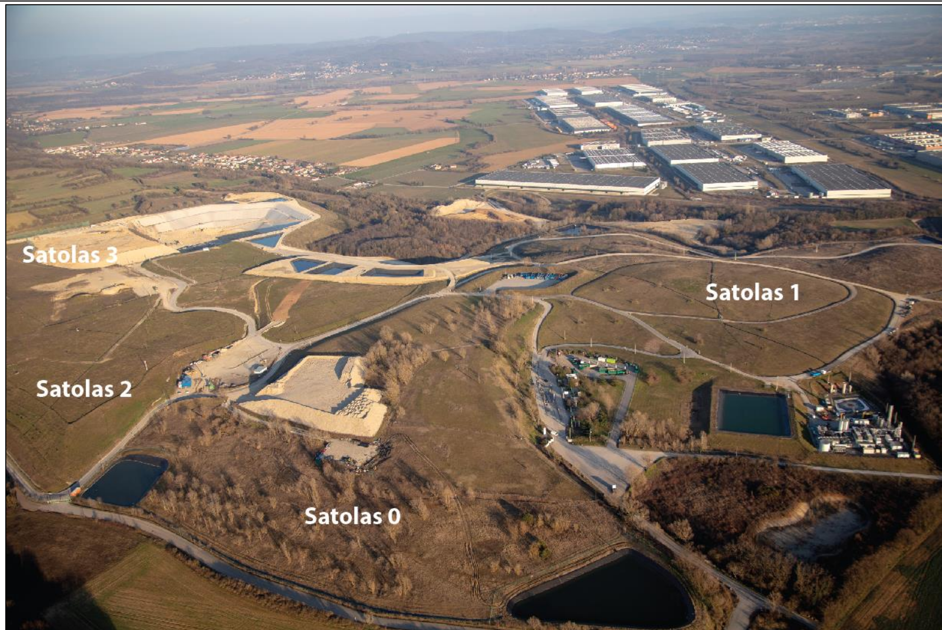
Figure 23 : Vue aérienne récente du site (Source : SUEZ fin 2018)
