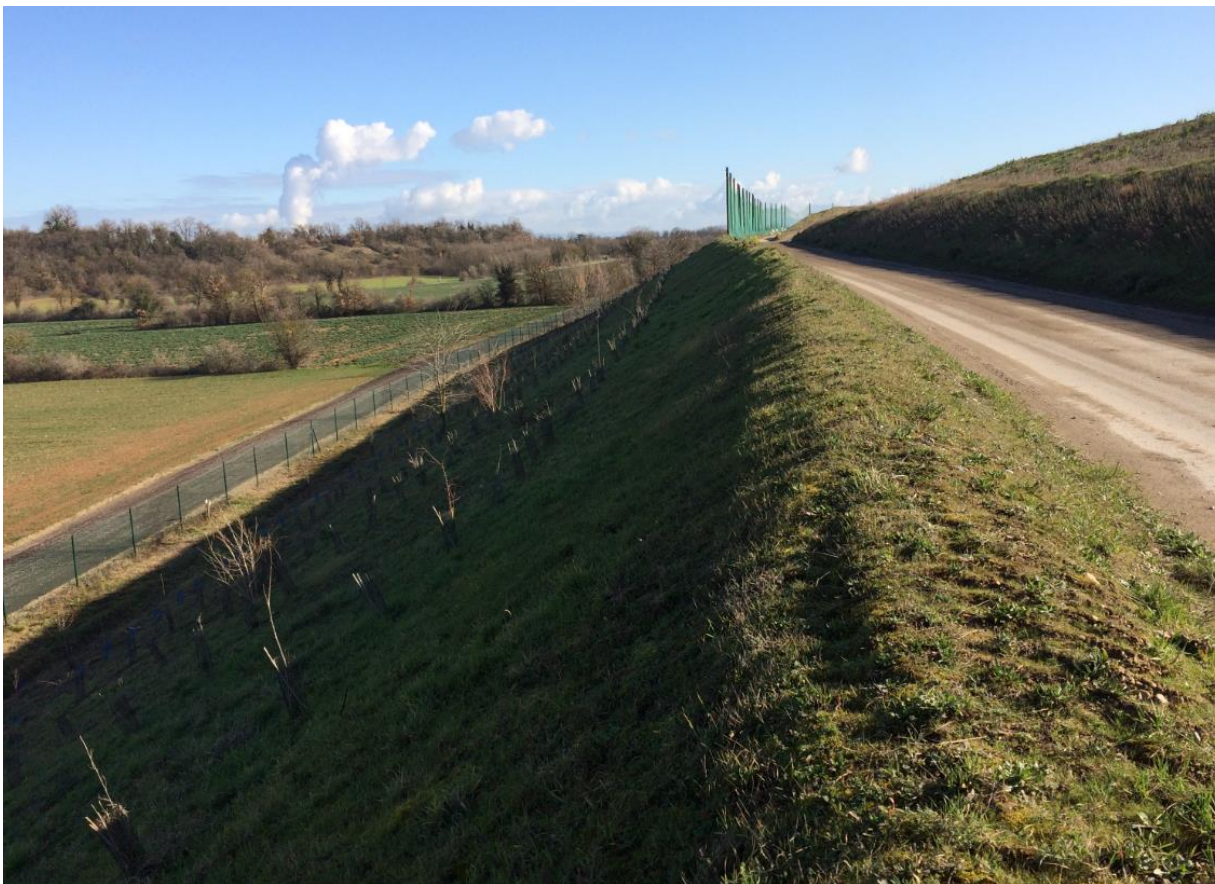
Figure 32 : Vue n°8 – Nord : Clôture, plantations d'arbre et filets anti-envol (Source : EKOS 12/02/2020)
