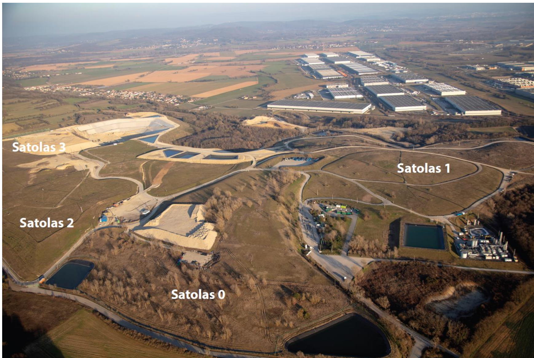
Figure 4 : Vue aérienne récente du site (Source : SUEZ fin 2018)
