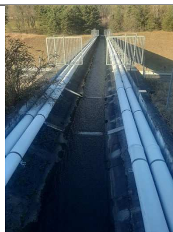
photo 4 : pont canal bétonné
