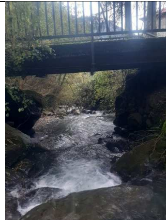
photo 16 : vue sur le Dière aval sous le pont du Moulin
