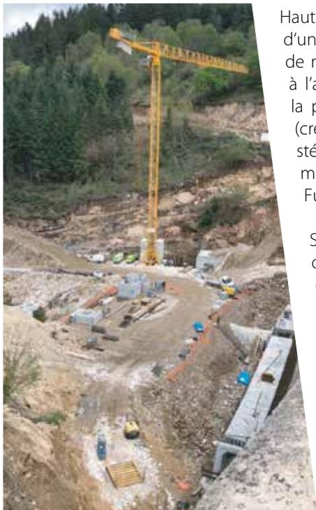
Haut de 35 m, long de 154 m et d'une capacité de près d'un million de m<sup>3</sup>, le barrage du Pas du Riot sert à l'alimentation en eau potable et à la protection contre les inondations (creux préventif) de l'agglomération stéphanoise. Il a été construit en maçonnerie en 1878 sur la rivière le Furan.
