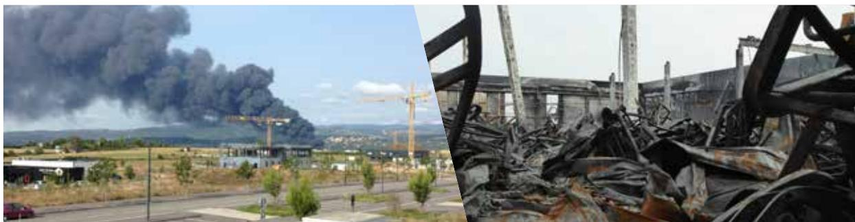
Dans le cadre des opérations, la mise en œuvre des moyens d'extinction s'est avérée bien supérieure aux besoins calculés. Le confinement sur site des eaux n'a donc pu être que partiel. De même, les exigences réglementaires, quant au caractère coupe-feu des portes entre les cellules, se sont avérées assez vite limitées, nécessitant rapidement un refroidissement permanent, complexe à mettre en œuvre.
