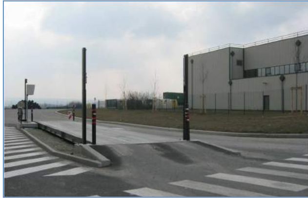
Pont bascule et portique de détection de radioactivité
