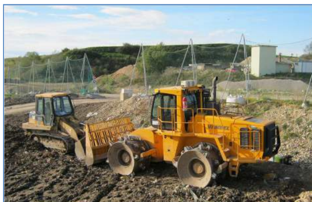
Engins de recouvrement et de compactage : Tracks CATERPILLAR 963 et compacteur VANDEL 250 30T
