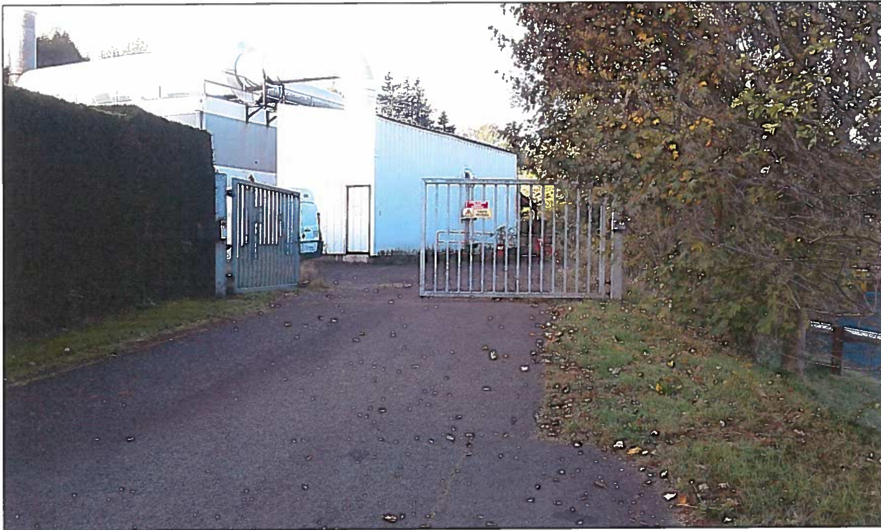
Photo 1 - Entrée chaufferie – Photo prise le 10/10/2018
