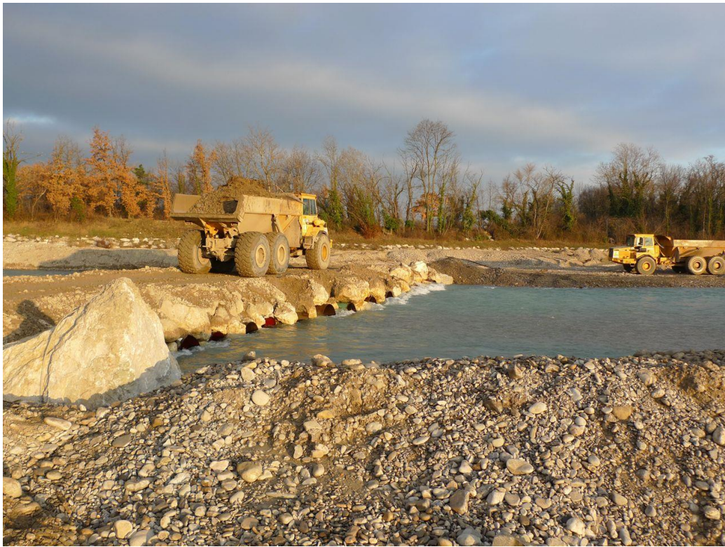
Figure 26 : Transport des matériaux de la tranchée en « Y » (en rive gauche) pour construire la risberme de protection de la digue d'Allex (rive droite)
