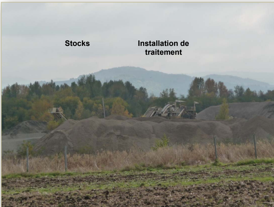
Vue 4 depuis le chemin d'exploitation au nord du site – Commune des Martres-d'Artière
