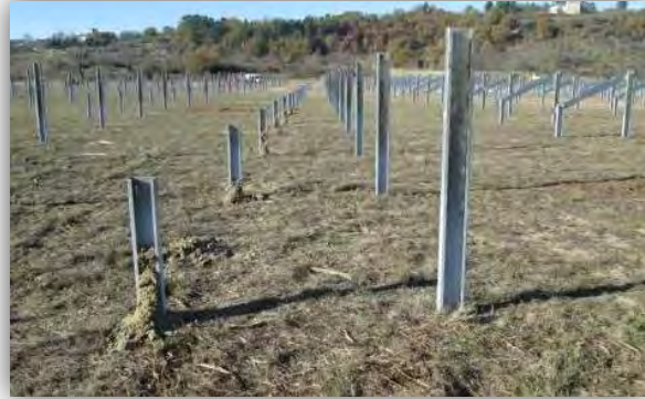
Battage de pieux
