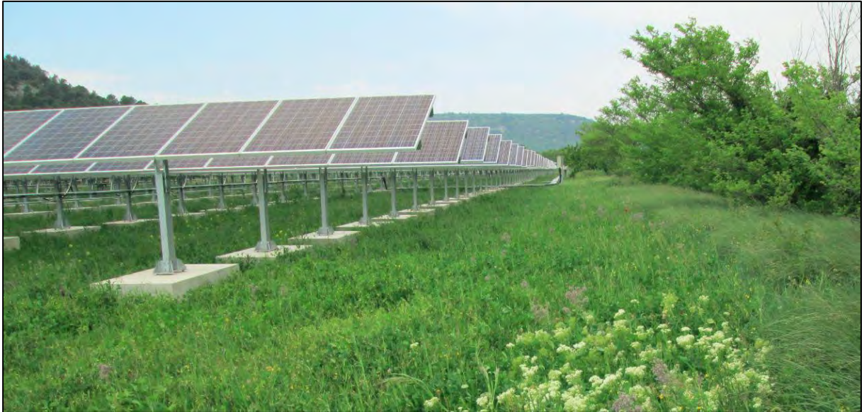
Photo du parc de St Restitut (26) fondé sur plots béton construit et exploité par CNR
