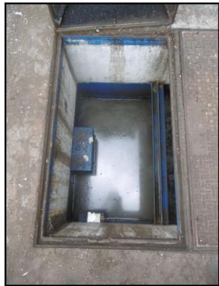
Séparateur à hydrocarbures n°1 avec grille ( Photo 2 sur le plan)
