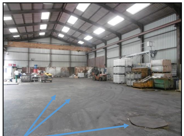
Grilles EP et regard de collecte EP sous le hangar 1 ( Photo 4 sur le plan)
