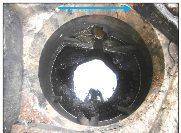
Entrée du séparateur à hydrocarbures n°2 Fe : 0,75m ( Photo 5 )
