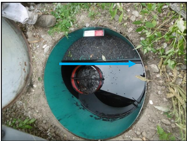
Sortie du séparateur à hydrocarbures n°3 (Photo 8)
