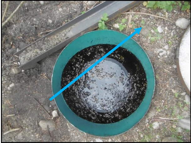
Entrée du séparateur à hydrocarbure n°3 (Photo 7)
