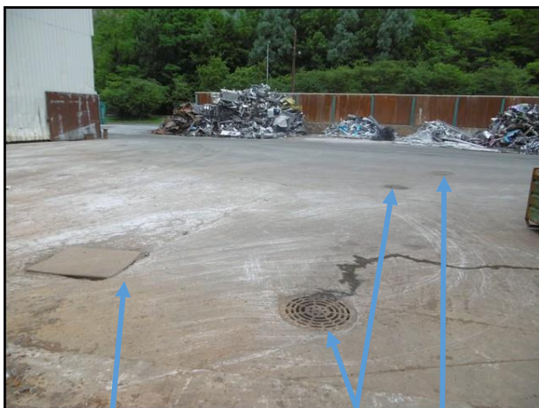
Regard de collecte EP, grilles EP et puits d'infiltration du pont bascule ( Photo 3 sur le plan)
