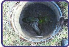
Présence derrière les appartements d'une FSTE en charge, d'un filtre enterré suivi de d'un regard exutoire
