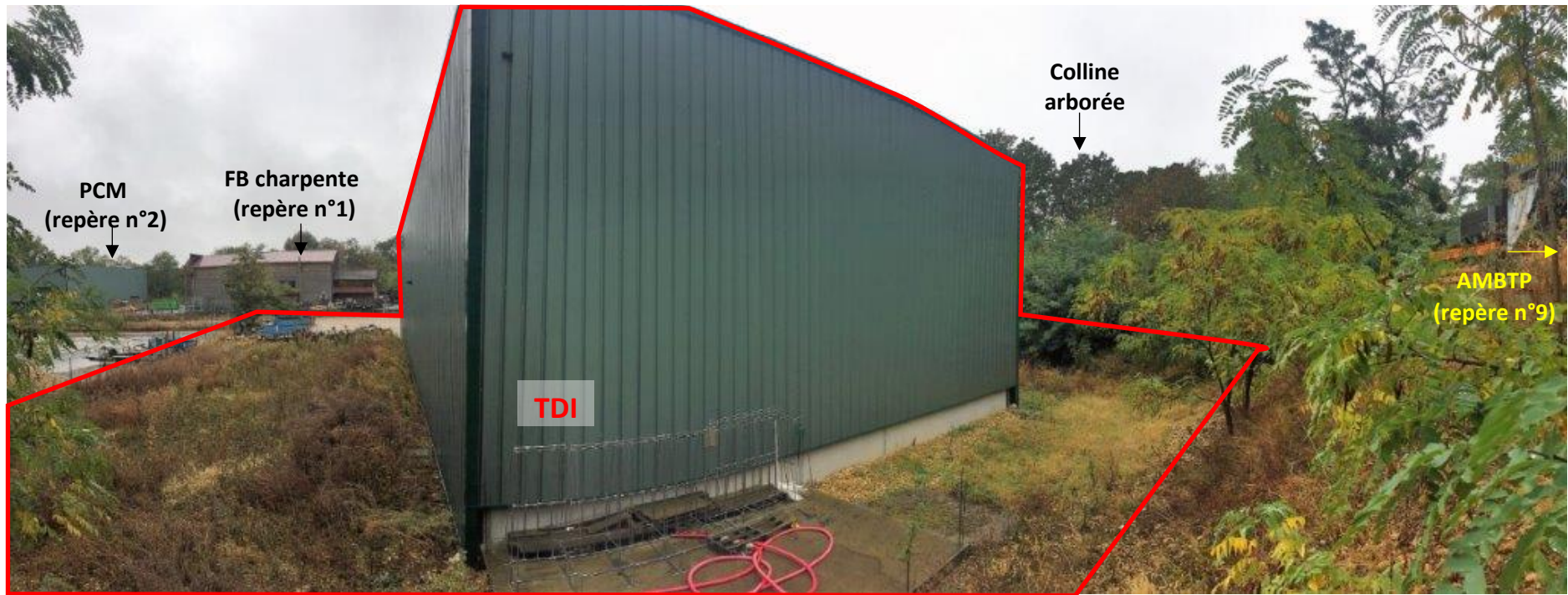
Photo de TDI dans son environnement proche – Prise de vue n°2, depuis l'angle nord-est du bâtiment (photo d'octobre 2018)
