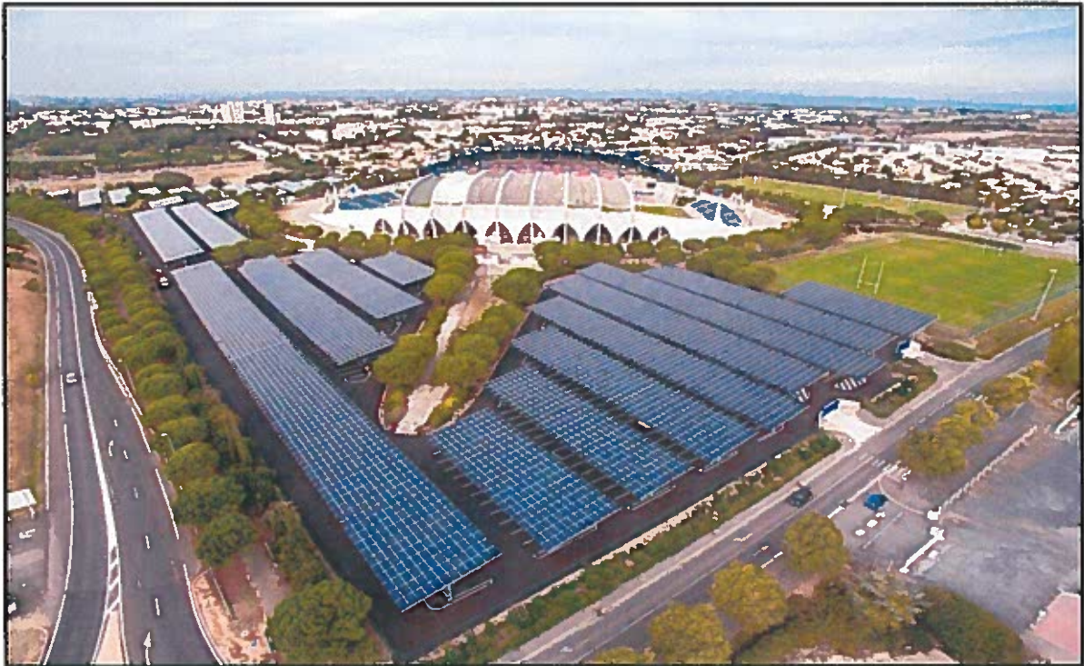
Figure 2: Exemple de réalisation Quadran - Parking du stade de la méditerranée
