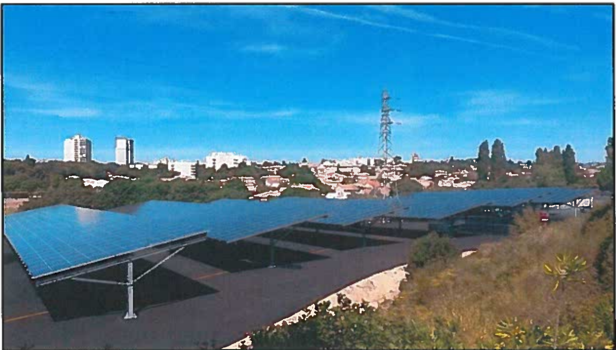
Figure 3: Exemple de réalisation Quadran - Parking du stade de la méditerranée 2
