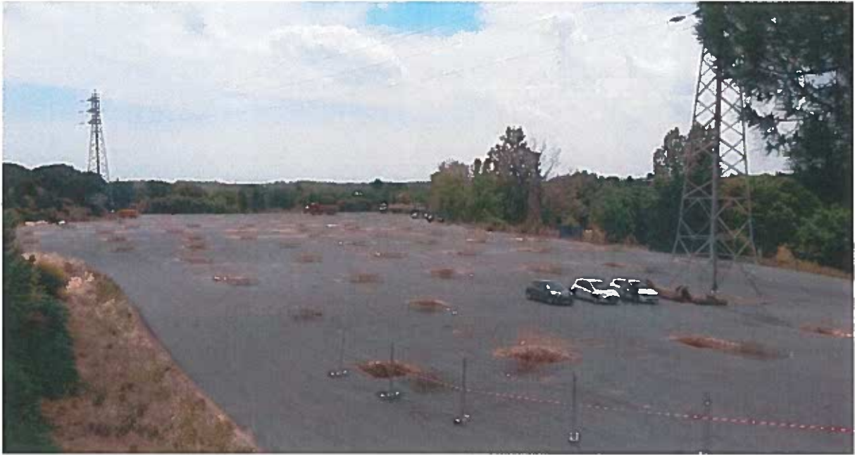
Creusement des fondations
