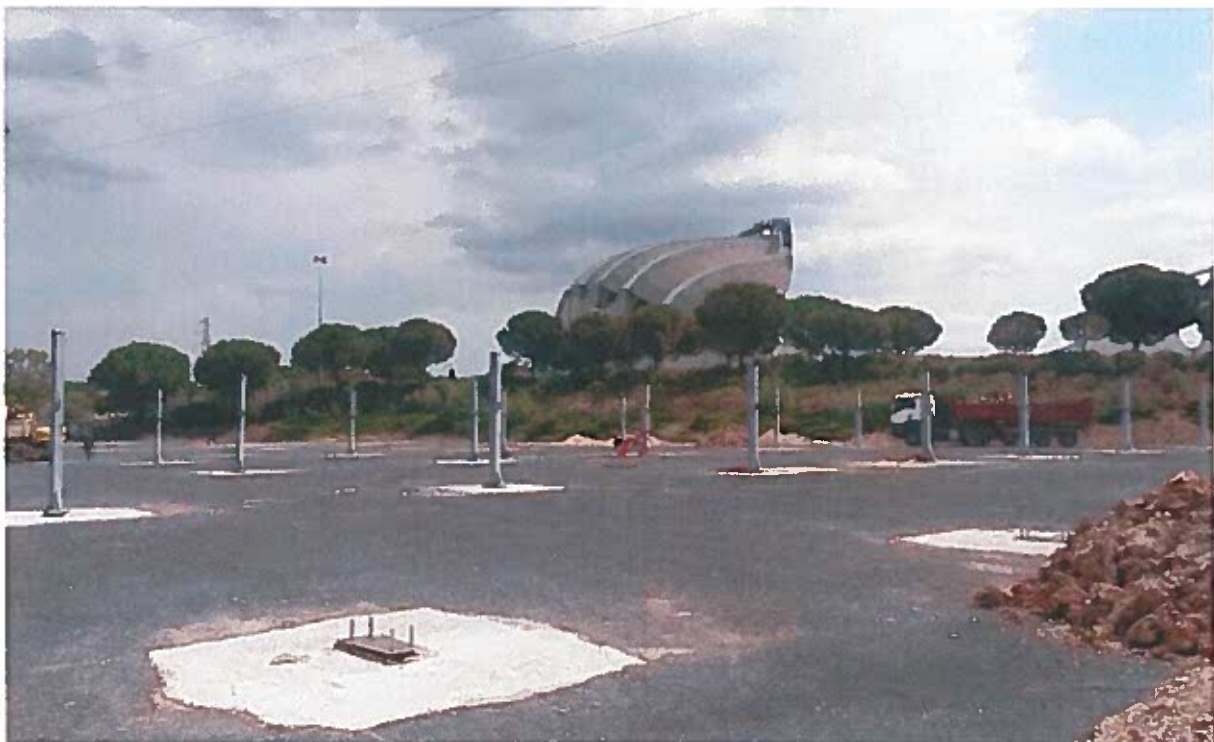
Coulage des fondations et pose des poteaux
