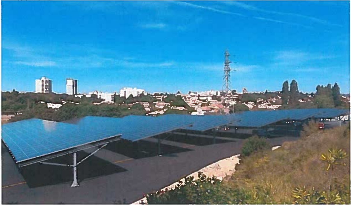
Vue du parking
