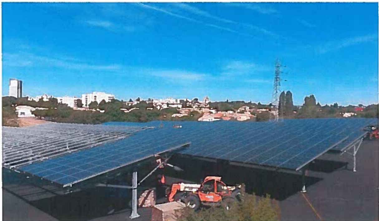
Pose des modules
