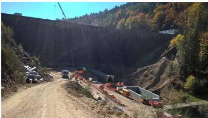
Les travaux doivent se terminer à l'automne 2018 avec la mise en service du nouvel évacuateur de crues et l'achèvement de la recharge aval en enrochement de 40 mètres de haut et de quatre mètres d'épaisseur en crête.
