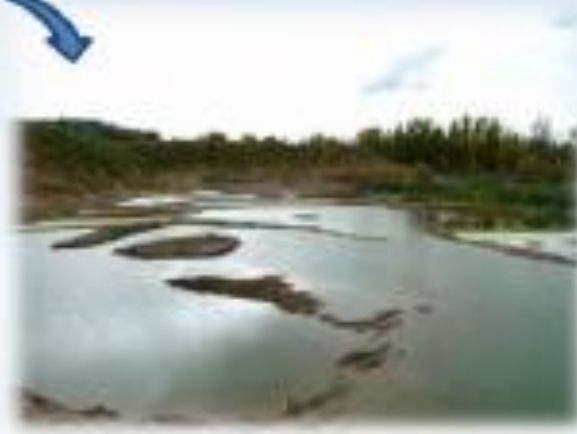
Retalutage des berges du bassin de Bellerive
