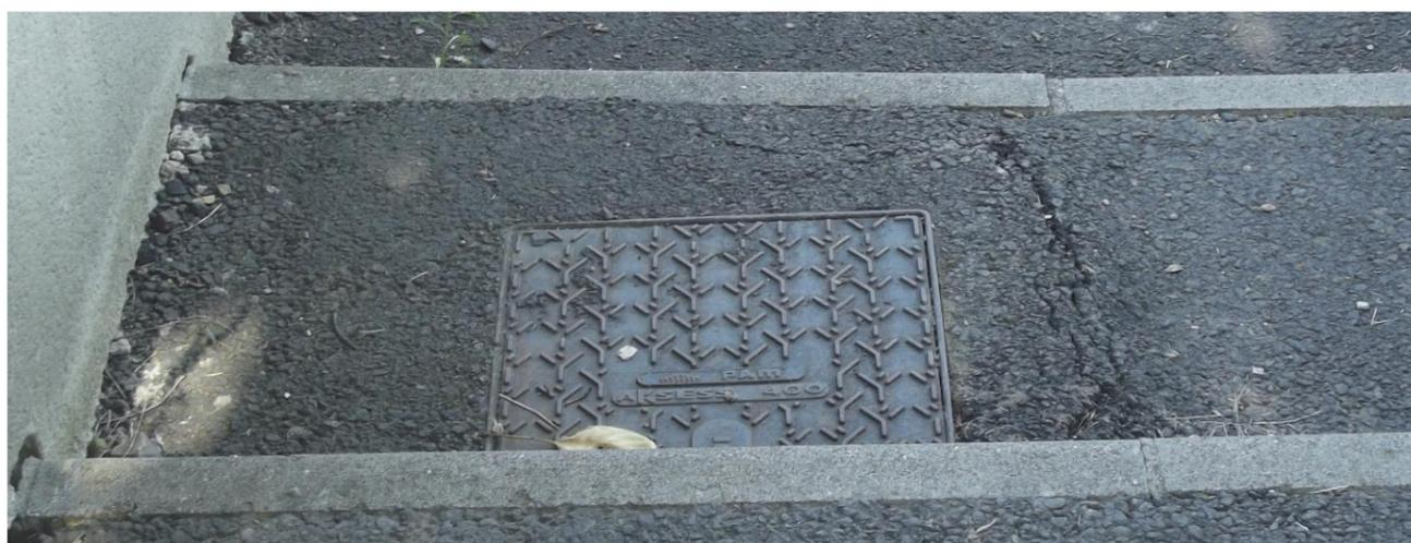
Photo 4 : Déformation du sol engendrant des dégâts sur la voirie
