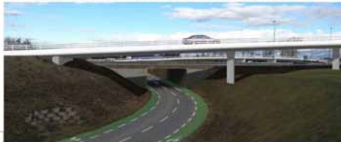
Vue depuis le chemin du chantre
