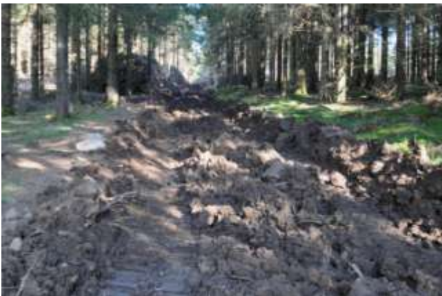
Figure 23 : Piste d'exploitation dans l'ENS pendant les travaux.
