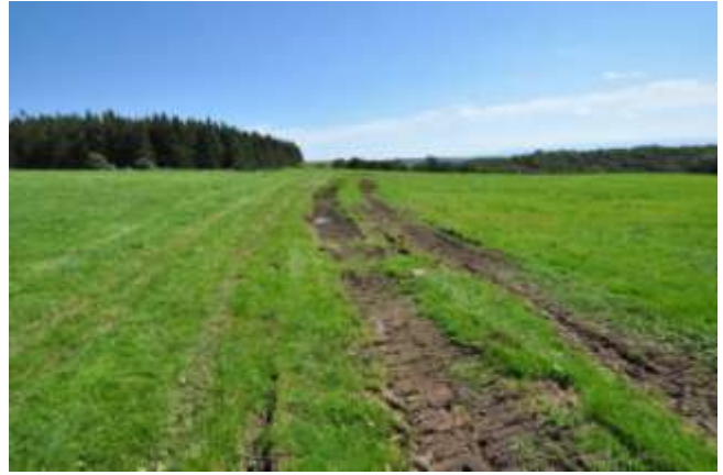
Figure 18 : Evolution du chemin pendant les travaux.
