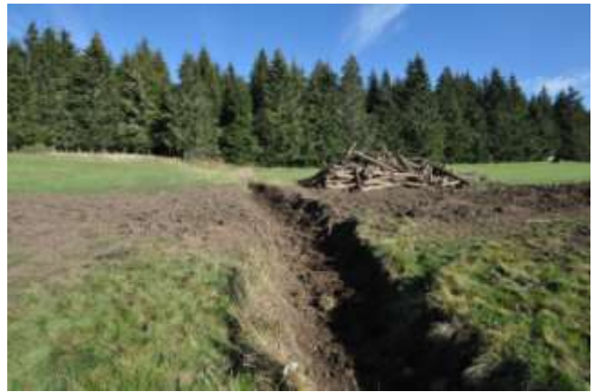
Figure 22 : Démontage du kit de franchissement et remise en état après les travaux.
