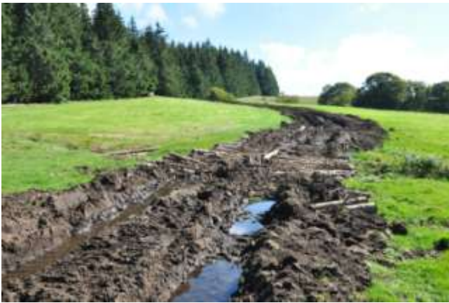
Figure 21 : Franchissement du fossé de drainage dans la prairie de M. Audebert, pendant les travaux.
