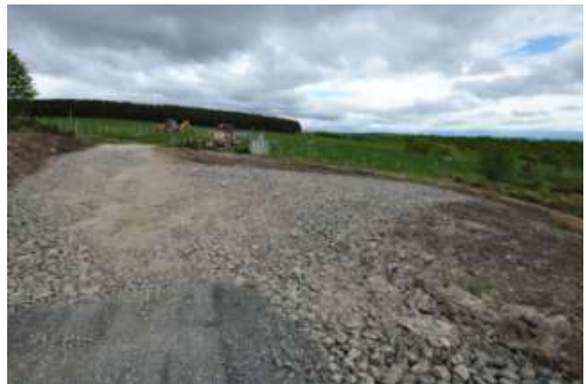
Figure 5 : Aménagement de la place de dépôt (zone sans concassé) et de contournement.
