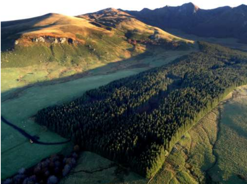
Figure 1 : Vue de l'ENS pendant les travaux.
