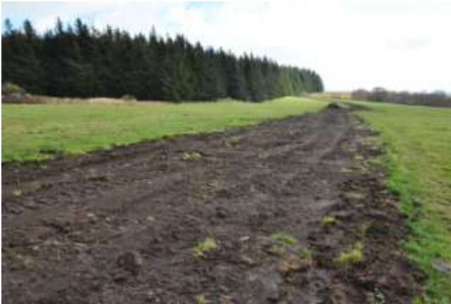
Figure 19 : Remise en état de la servitude de passage.
