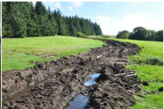
Figure 28 : Passage du fossé.
