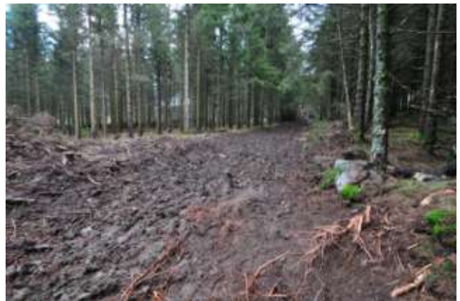
Figure 24 : Remise en état de la piste d'exploitation.
