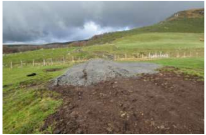
Figure 20 : Remise en état de l'entrée de la prairie de M. Audebert après travaux.
