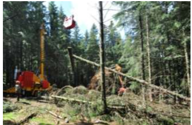
Figure 10 : Débardage aérien par la machine câble-mât.
