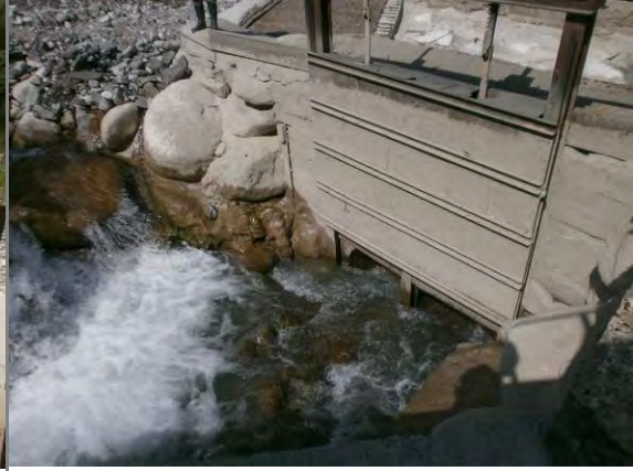
Vanne de dégrèvement ouverte
