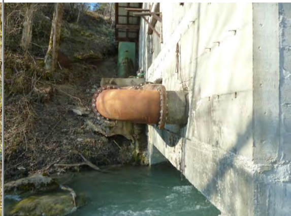
Canal de fuite de la centrale
