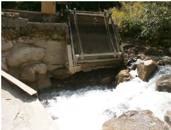
Prise d'eau en rive droite
