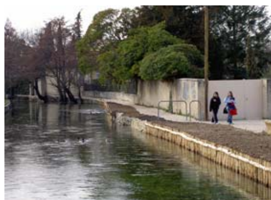
Figure 26- Aménagement associant réhabilitation des berges et création d'un chemin piétonnier (SMBS)
