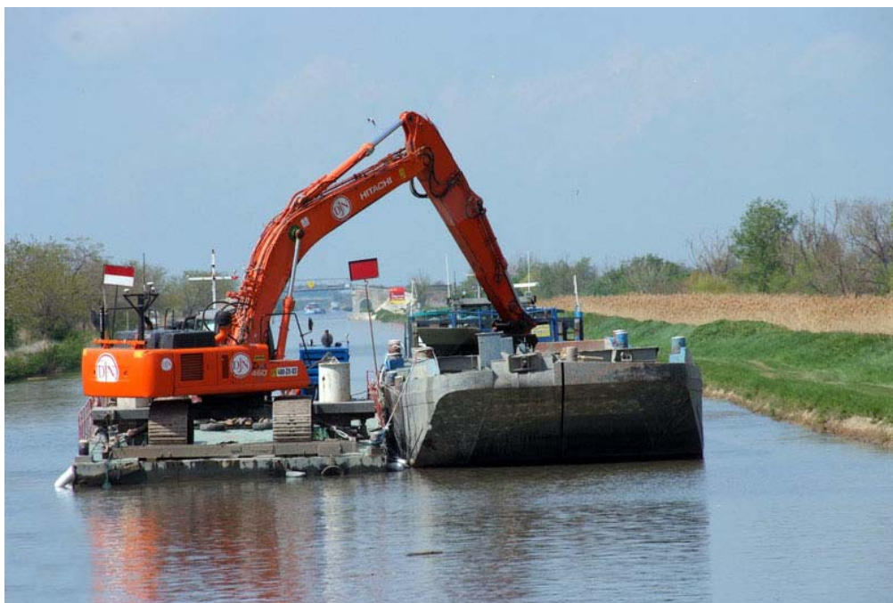
Figure 46 - Exemple de curage mécanique en eau à l'aide d'une pelle sur ponton (Jan de Nul)
