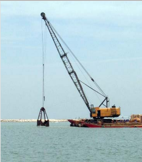
Figure 106 : Curage à l'aide d'une benne preneuse
