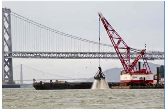
Figure 106 : Curage à l'aide d'une benne preneuse
