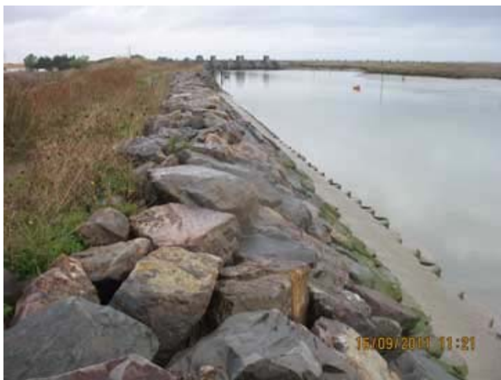
Figure 24 - Protection de digue par la pose d'enrochement (Arcadis)
