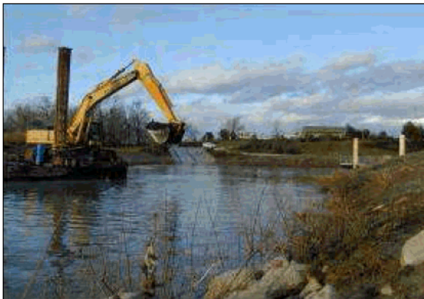
Figure 76 – Pelle sur ponton pour sites avec profondeur <10m.
