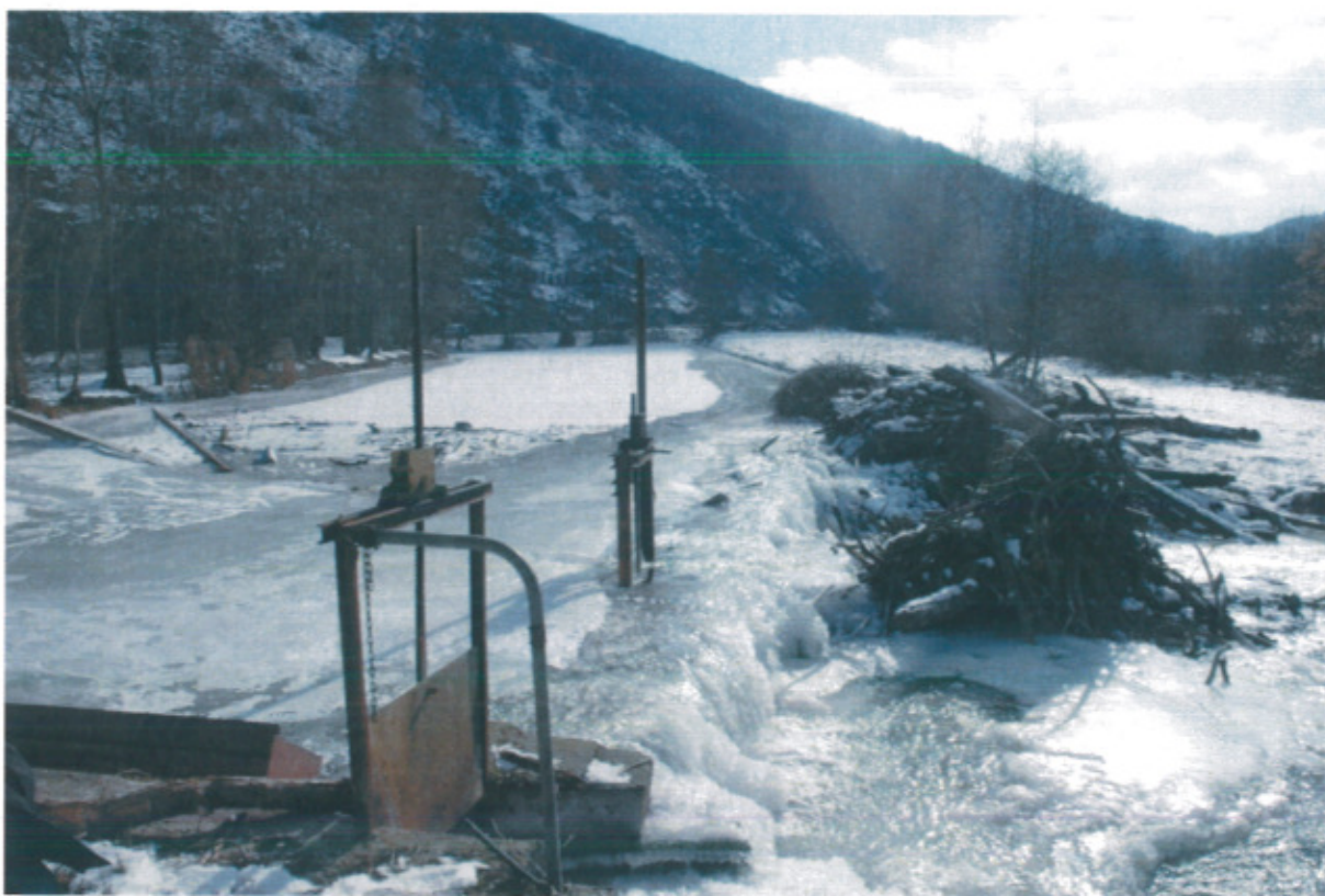
Photographie P4 – Canal amenée
