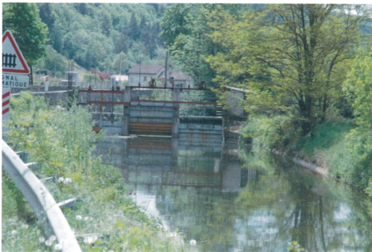
Photographie P1 – Canal amenée et prise d'eau
