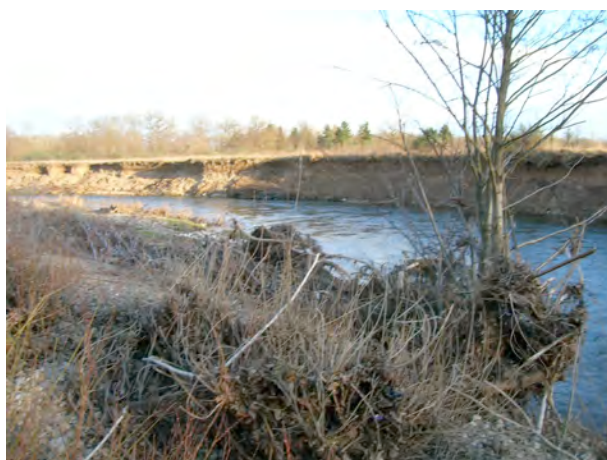
Érosion sur le Lignon vers les Périchons
