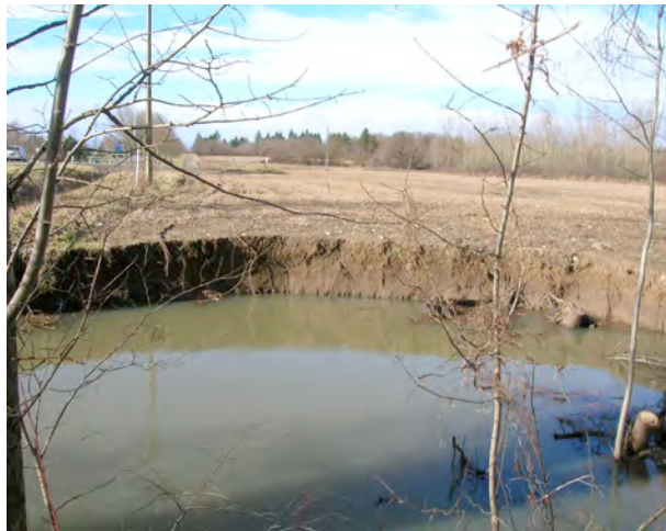
Érosion sur l'Aillot vers le Marais
