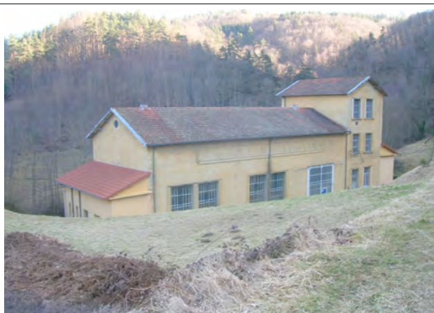
Usine hydroélectrique de Rory – Saint Georges-en-Couzan
