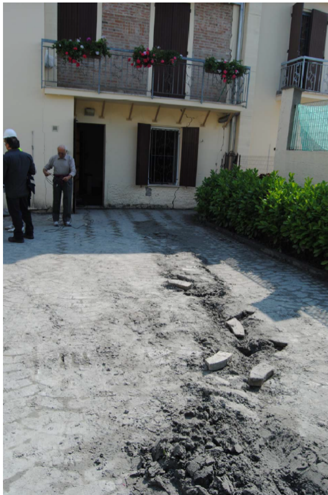
Rapport UNIFER – Université de Ferrara Fioravante, Giretti Fissuration du sol et du mur
