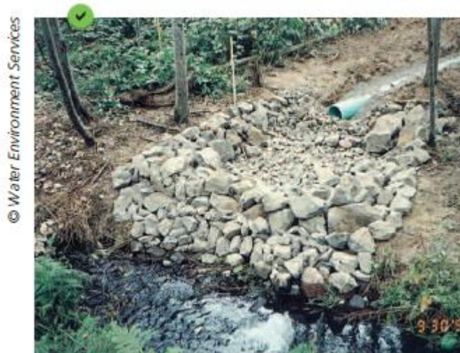
Dispositifs temporaires de protection des points de rejet à l'aide de tas de graviers et de blocs installés en amont du lit mouillé des cours d'eau
