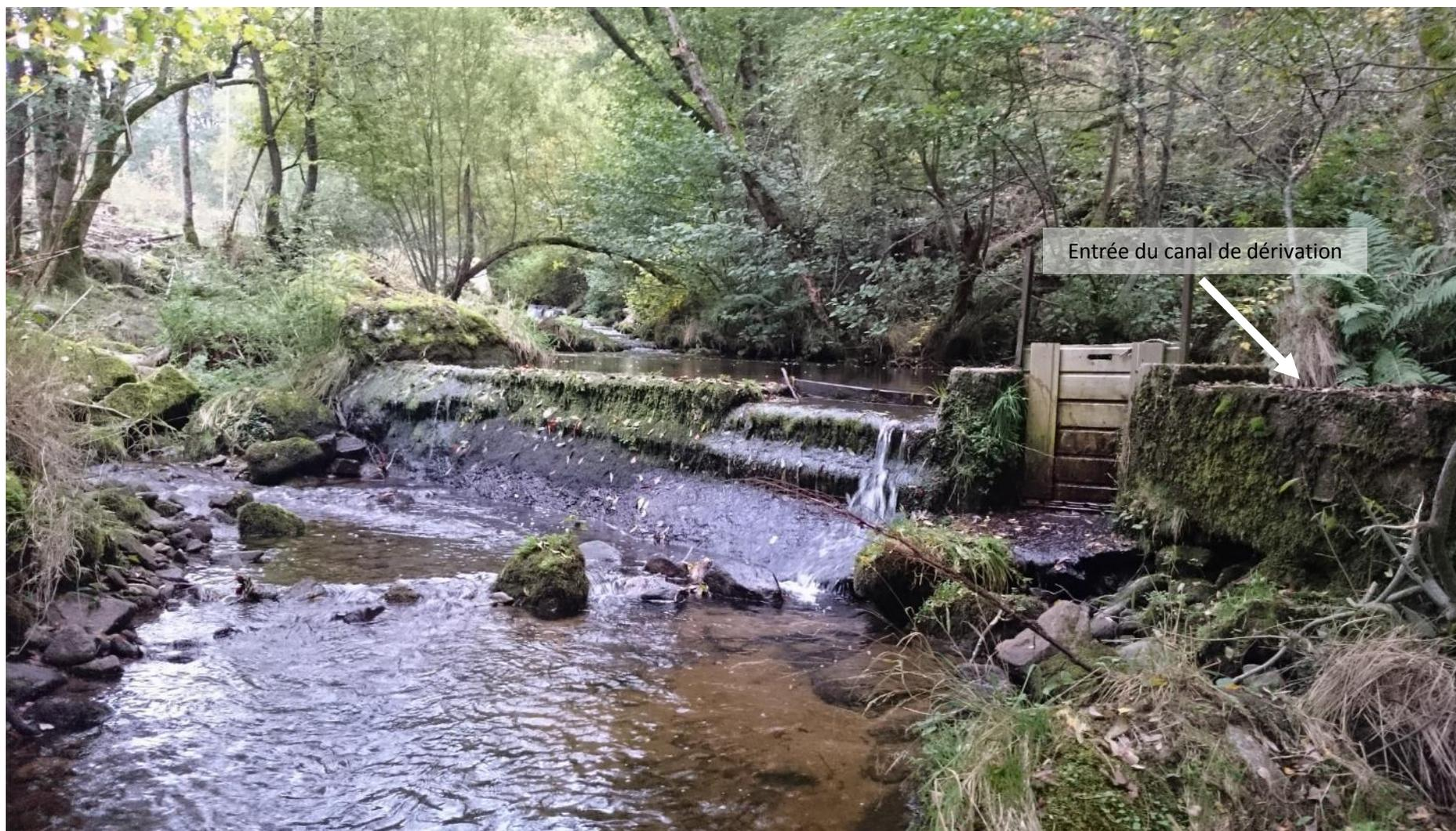
Figure 3 : Barrage de la MCHÉ en étiage – vue depuis la rive gauche
