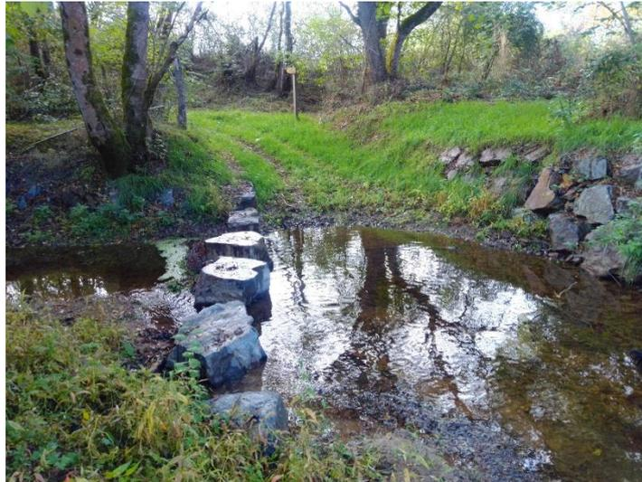
**Figure 9 : Exemple de mise en œuvre de pas japonais sur sentier de randonnée pédestre**
