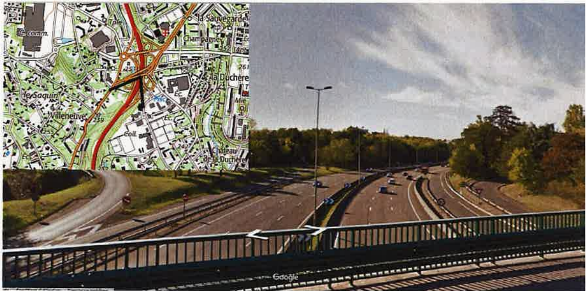
Vue Section Nord – Orientation vers le Sud (Source : Google maps)
