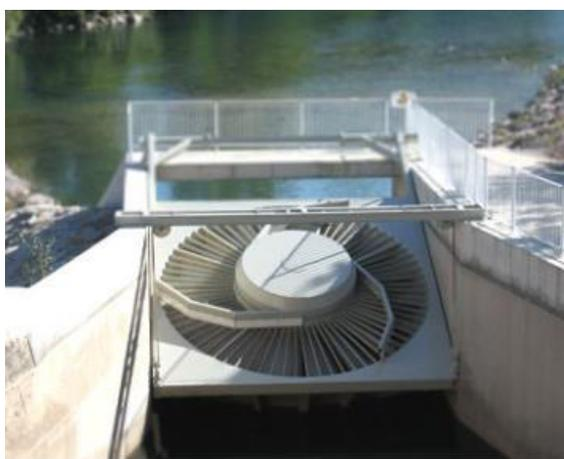
Figure 7 : Exemple de machine VLH installée
