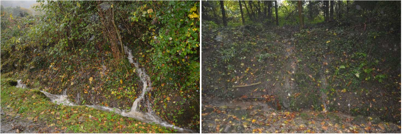
Vues de l'arrivée d'eau du ru et des petites arrivées d'eau depuis le talus.
