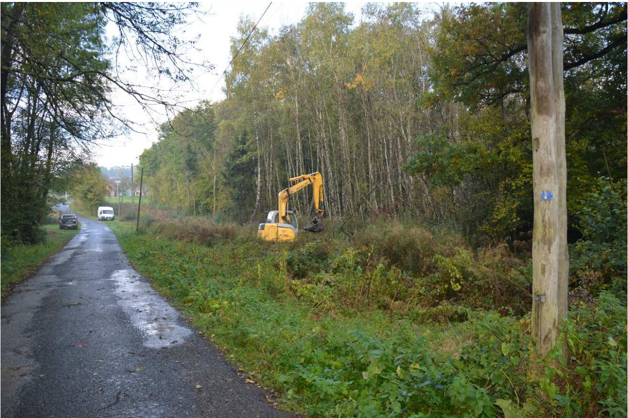
Vue du sondage S2 en cours. La zone humide est comprise entre le poteau et le véhicule noir, de part et d'autre de la route.
