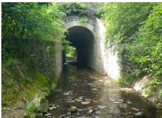
Pont sous la voie ferrée et lit pavé © BIOTOPE -
