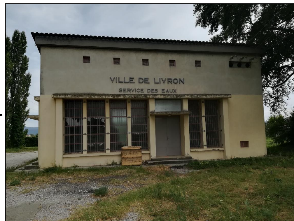
VUE 1 : VUE DU LOCAL D'EXPLOITATION DU CAPTAGE DE COUTHOL VERS L'OUEST / NORD-OUEST
