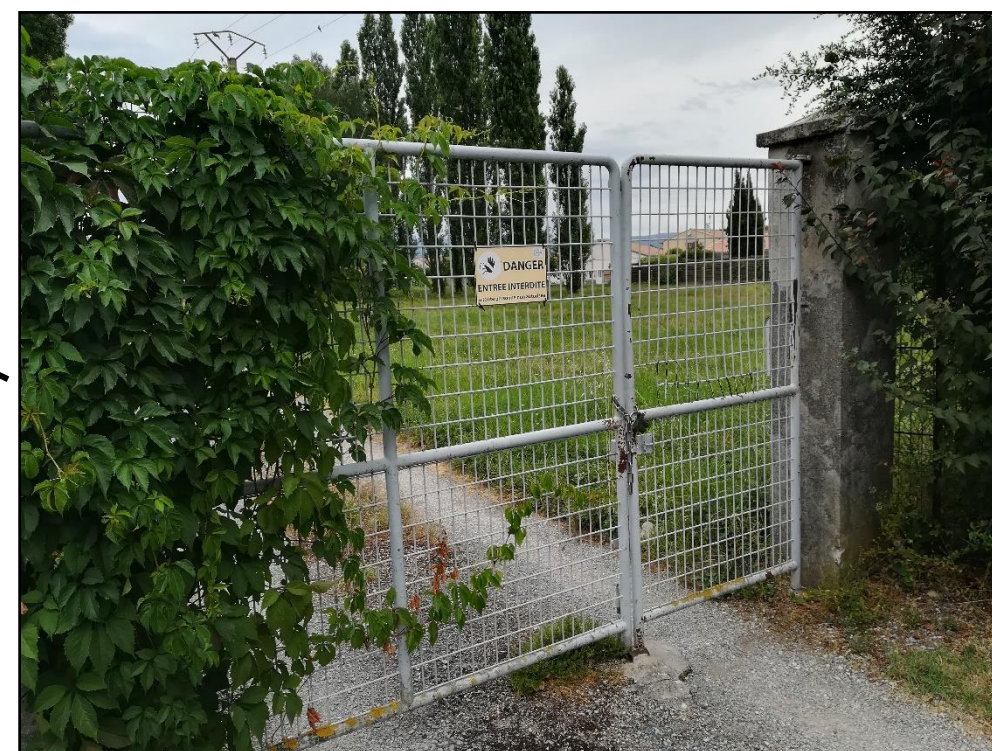
VUE 2 : VUE VERS LE NORD-OUEST DE LA PARCELLE DU PÉRIMÈTRE DE PROTECTION IMMÉDIAT DU CAPTAGE DEPUIS SON PORTAIL D'ACCÈS
