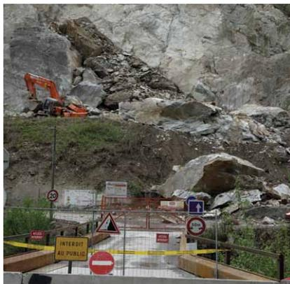
Si cet éboulement de l'ordre de 2000 m<sup>3</sup> n'a occasionné que quelques dégâts matériels sur des véhicules de chantier, il a toutefois rendu nécessaire l'interruption temporaire du chantier à proximité de la zone d'éboulement.
