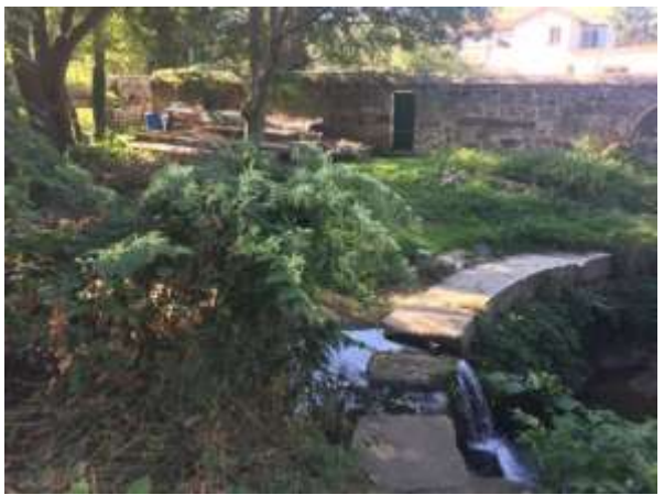
Dépôt de planches dans la zone d'expansion des crues du Janon
