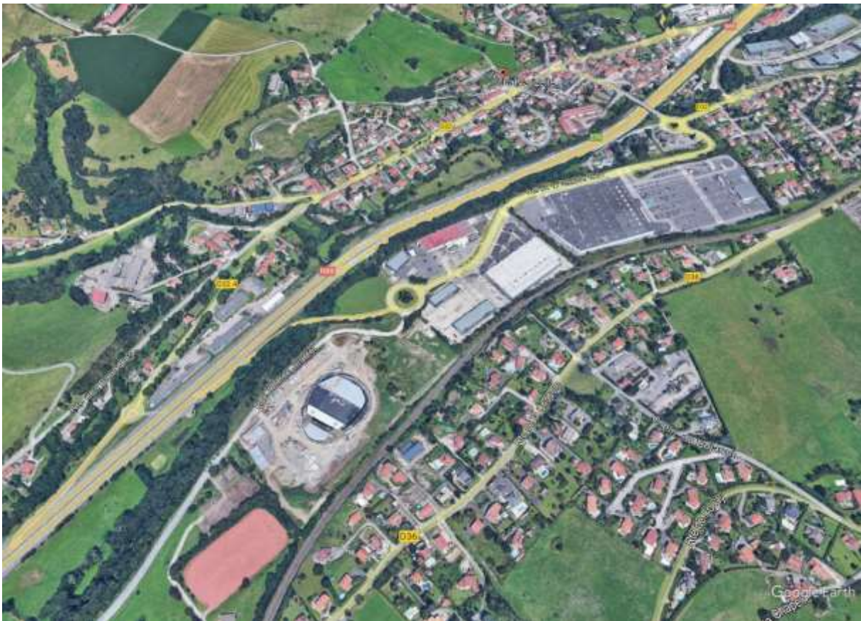
Vue aérienne du demi-échangeur existant n° 17 à La Varizelle (source Google Earth)
