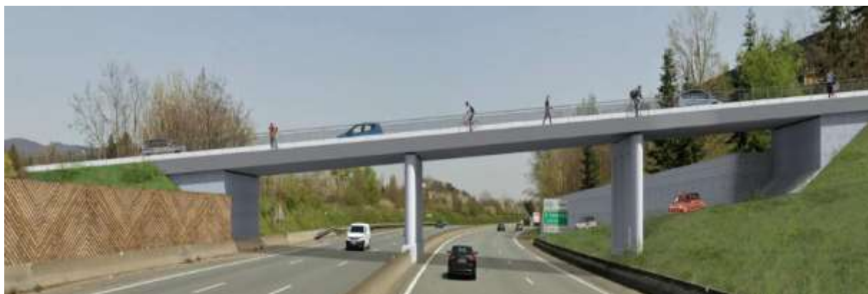
Illustration du barreau de franchissement du Nord (à gauche) au Sud (à droite). Document du maître d'ouvrage
