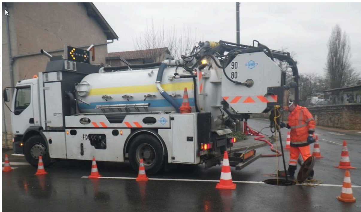
Figure 16 : Camion hydrocureur Huwer PTAC 16T
