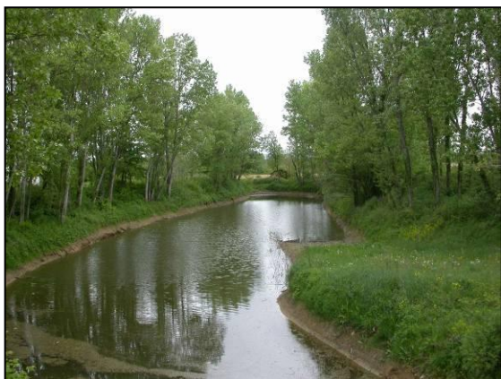
Au lieu dit les Epines Bénites se situe une zone humide artificielle d'une superficie d'environ 0,5 ha. Il s'agit d'un bassin de rétention recueillant les eaux de ruissellement de la plate-forme routière.
