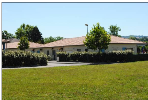
Quartier du Bellangeon
