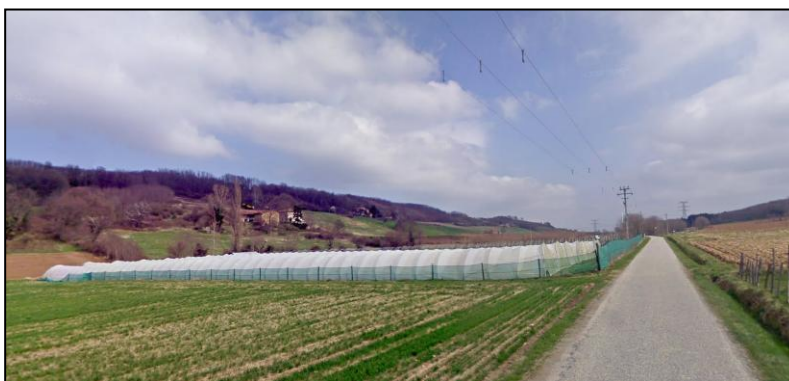
Les tunnels liés à l'activité de maraîchage
