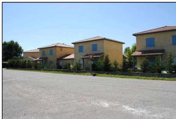
Quartier du Bellangeon
