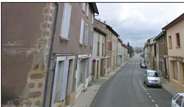
Zone intermédiaire Est : un point de fuite vers l'Est
