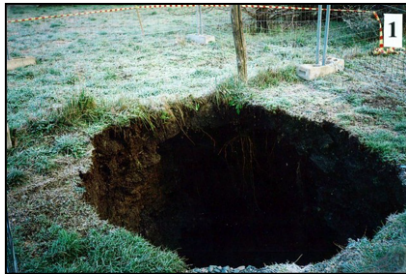
Exemple de l'effondrement sur le Puits Pacalon
