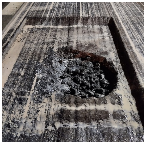
Aspect après décapage de la chaussée quelques semaines avant le désordre
