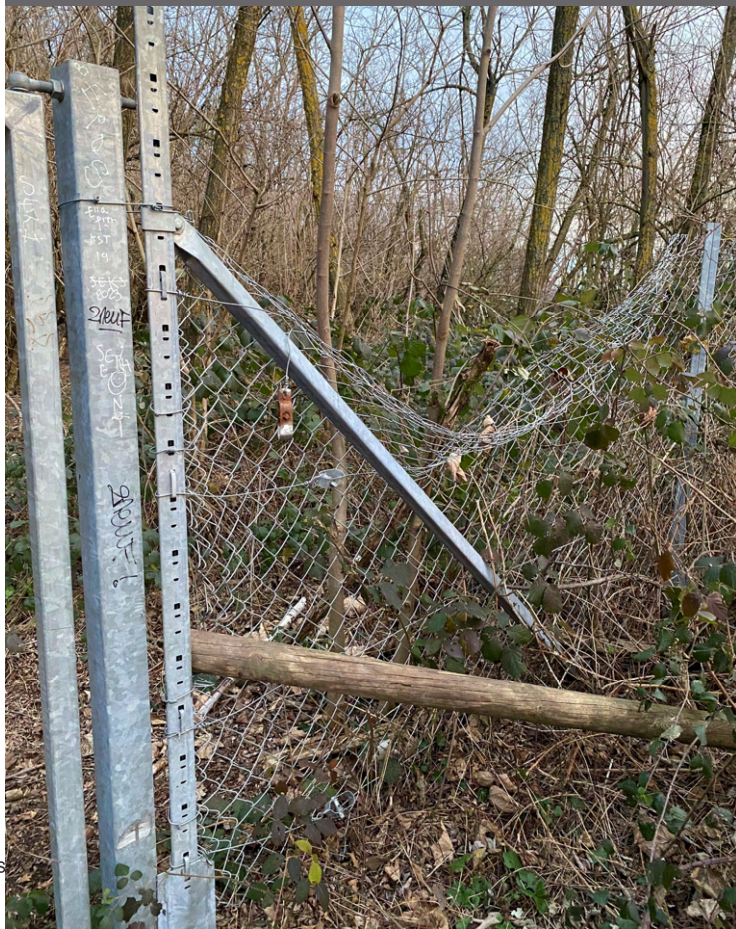
Endommagement récurrent des clôtures – Couriot A
