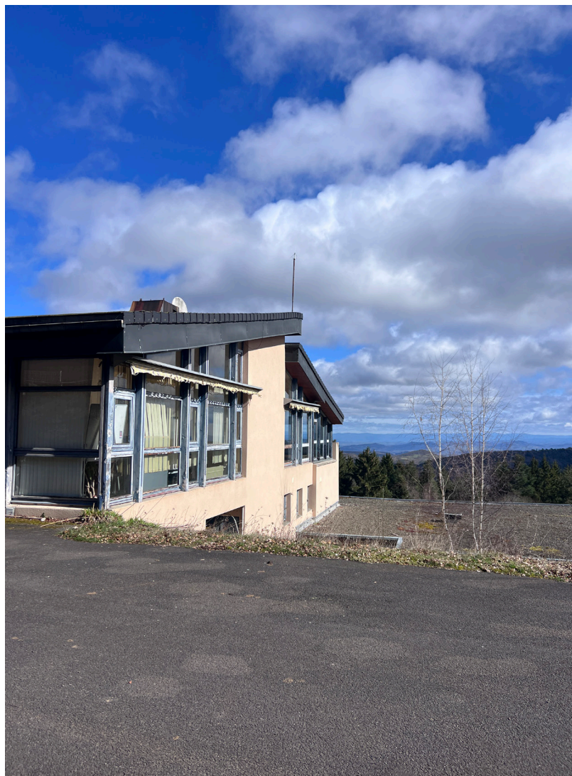
Photo j Photographie du bâtiment principal date de la prise de vue 2023
