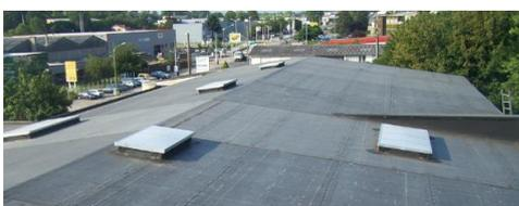
**Toiture BAC ACIER avec étanchéité bitume bicouche**
