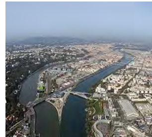
© Auvergne-Rhône-Alpes Energie Environnement
