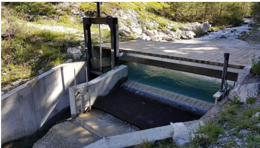
Figure 2 : Exemple de prise d'eau par en-dessous
