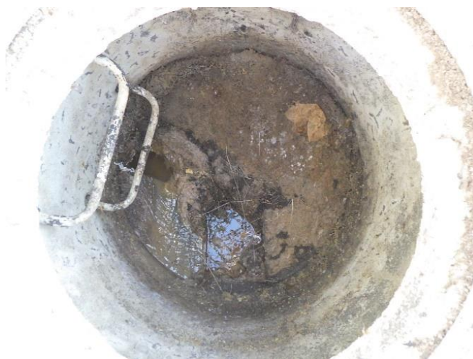
Dépôts – Réseau d'eaux usées
