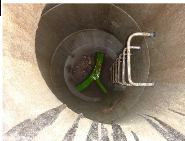
3 - validation de la connexion hydraulique à l'aide de colorant
