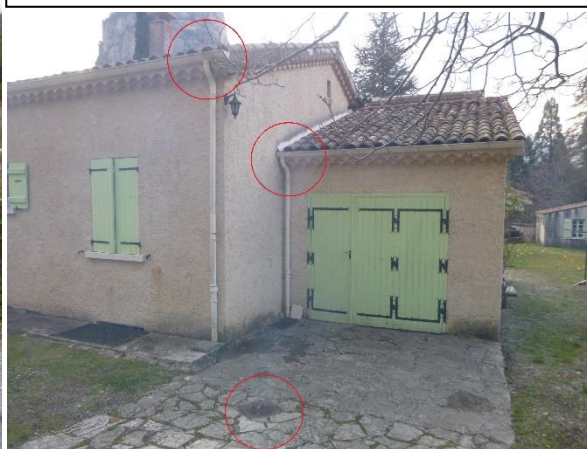
2 - identification de tous les organes laissant s'échapper la fumée
