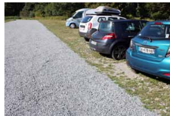
Voirie en concassé 0/25 et stationnement en terre pierre végétalisée
