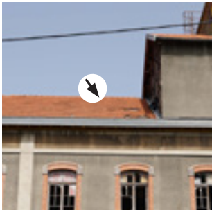
Tuiles mécaniques ponctuelle- ment désorganisées
