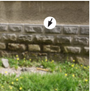
Humidité ponctuelle en pied de façade
