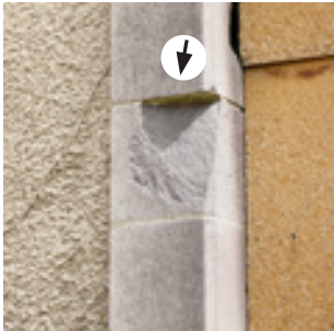
Pierres d'encadrement des baies ponctuellement cassées
