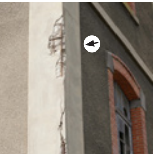
Armatures apparentes sur un angle en béton armé
