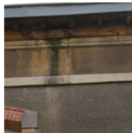
Exemple d'enduits devant être refaits
