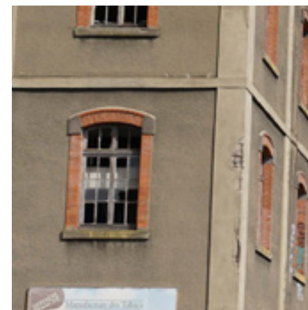
Exemple d'enduits devant être restaurés
