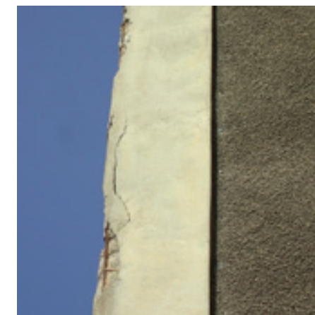
Exemple d'enduits devant être restaurés
