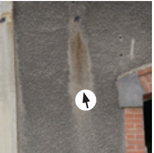
Salissures générales des enduits avec coulures localisées
