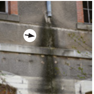
Descente EP cassée qui créent des coulures sur les façades
