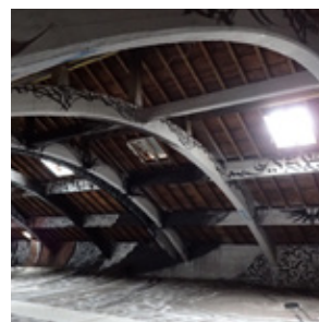
Charpente en béton armé
