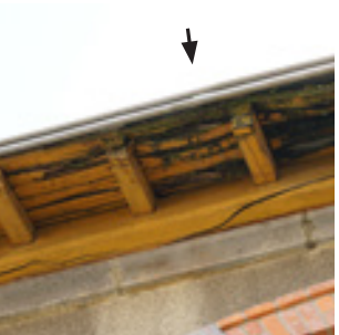
Fuites sur chéneaux qui dété- riorient les avant-toits
