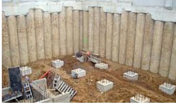
Figure 7. Exemple de construction par pieux sécants
