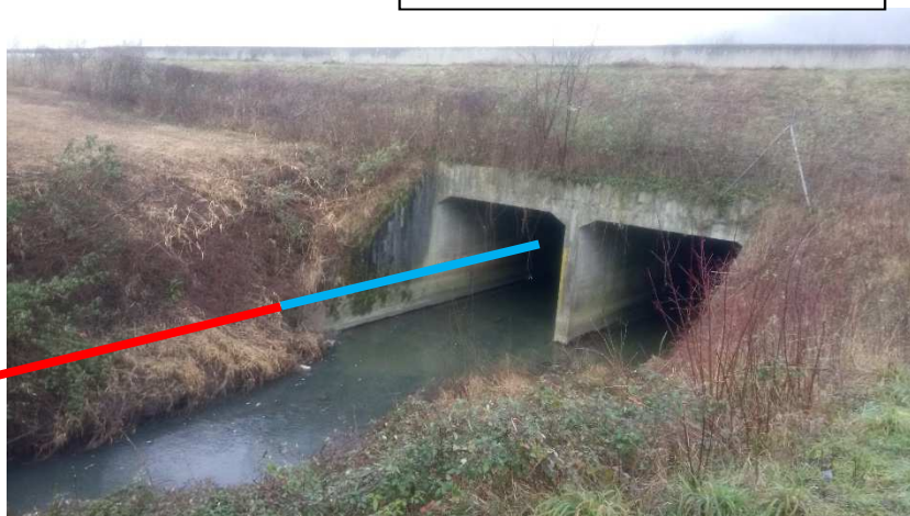
Figure 18 : Ouvrage cadre - aval du passage sous l'autoroute
