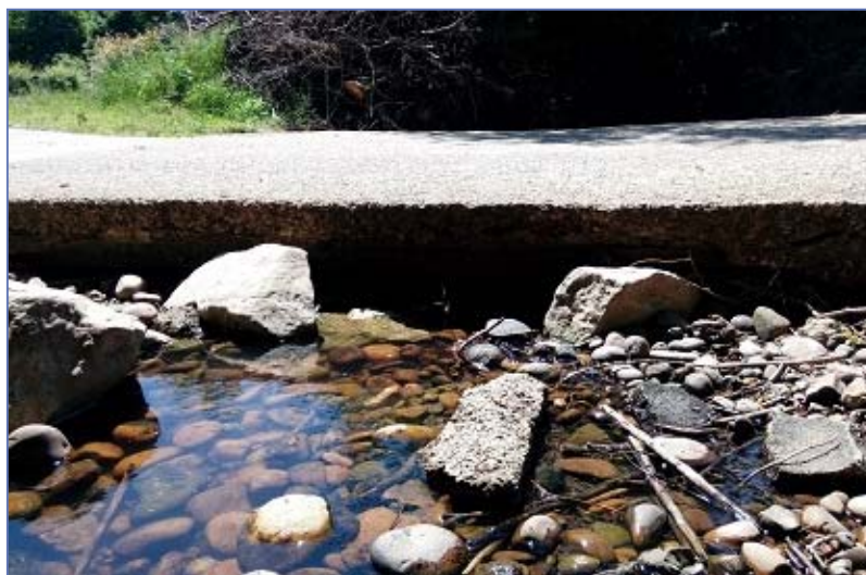
Ouvrage de franchissement (Ø300 B) à l'amont et à l'aval de la route des Vignes
