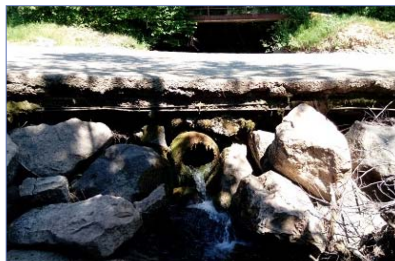
Ouvrage de franchissement (Ø300 B) à l'amont et à l'aval de la route des Vignes
