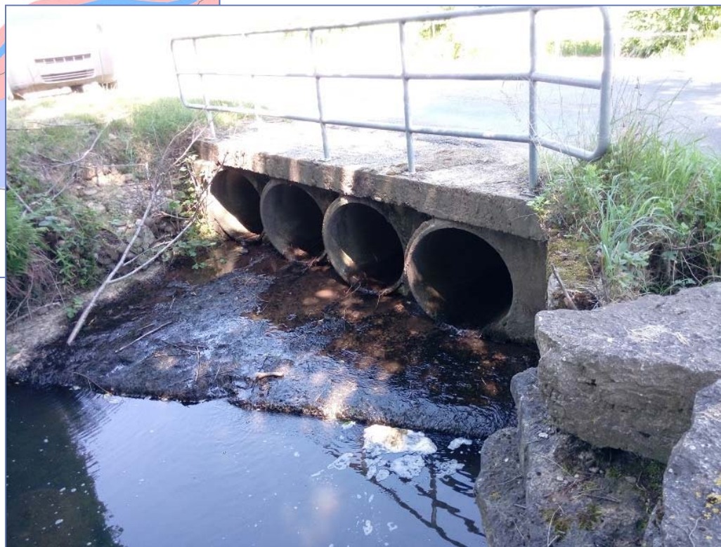
Ouvrage de franchissement de la Varèze sous la route de Villeneuve (4 x Ø800 B)
