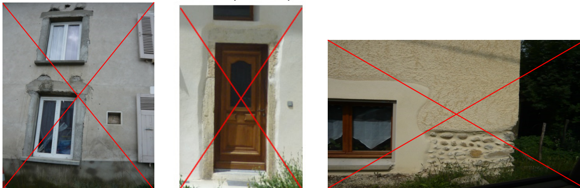
Des finitions d'enduit interdites car en saillie ou découvrant le soubassement.
