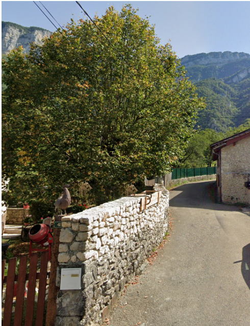
A gauche, rehaussement de clôture en pierres dans le centre village. La clôture en pierres marque le front de rue sans créer l'effet de cloisonnement des murs enduits.
