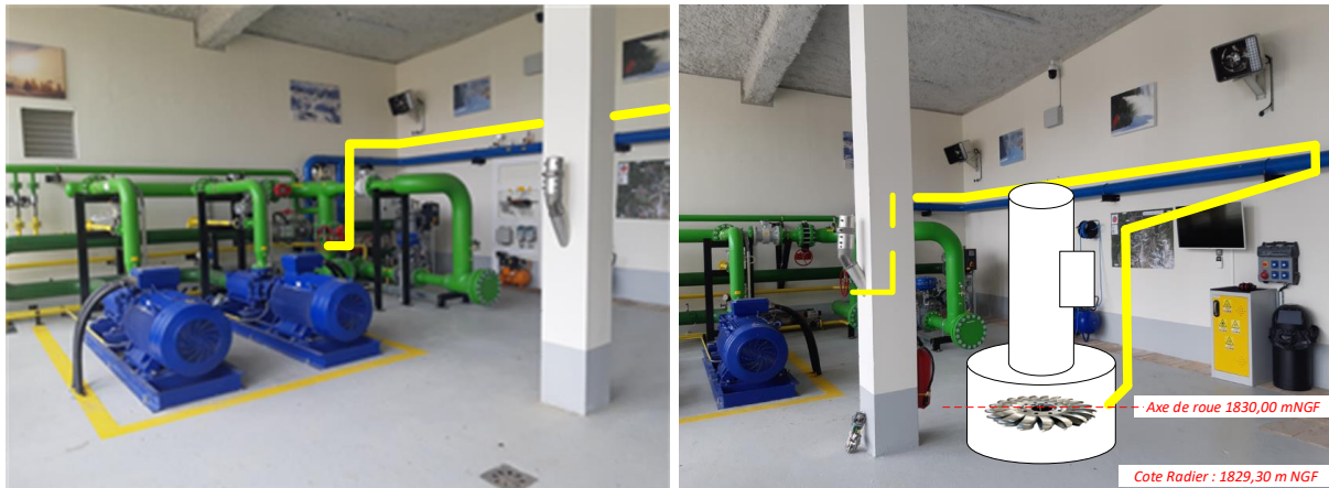
Figure 7 – Implantation du groupe de turbinage dans la SDM Pré Saint Esprit
