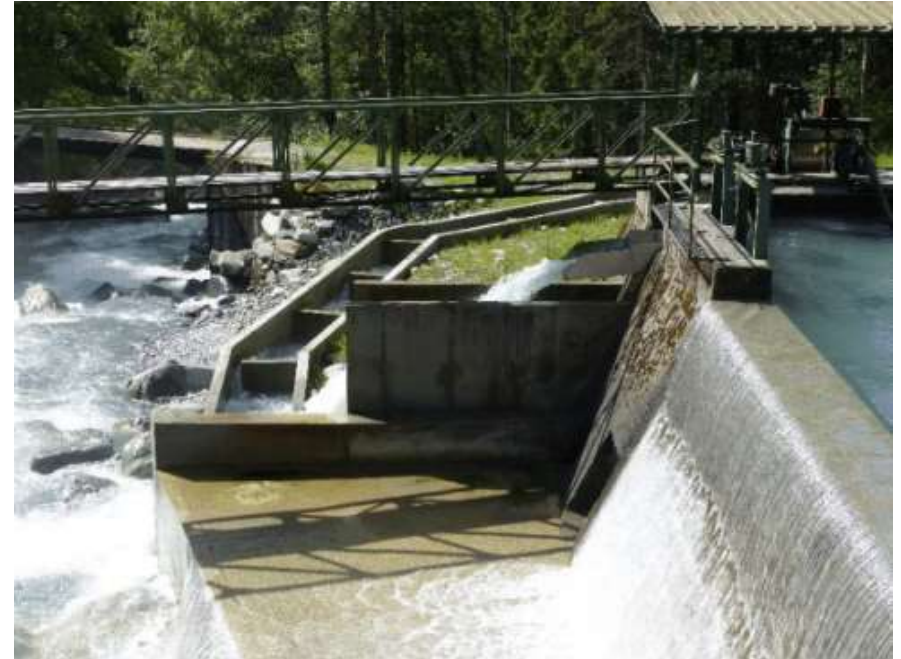
Photographie 4 – Passe à poissons centrale de Bonneval
