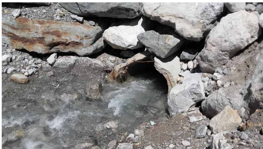
Buse de la plage de dépôt RTM, cote 1450 m, en juillet 2017, débit estimé à 40 l/s
