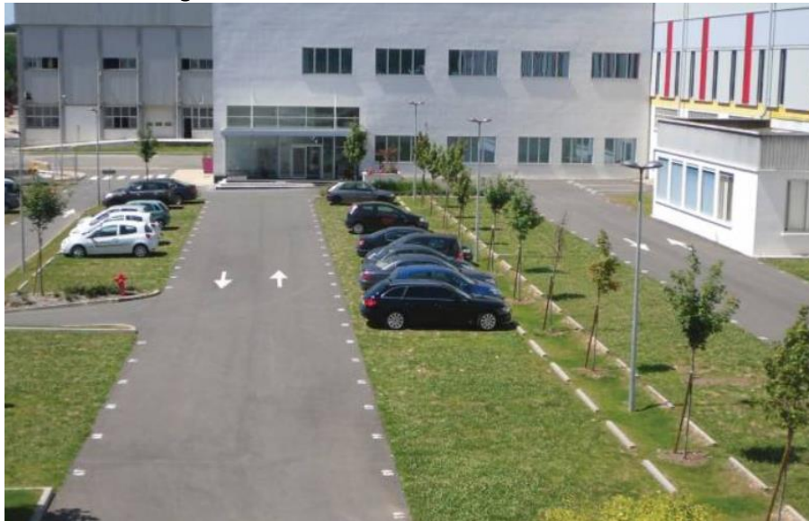
Figure 47 : Exemple de gestion des eaux pluviales par la mise en place de parking infiltrants (ecovegetal.com)
